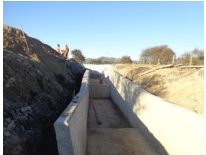
Caída vertical, Km 11.200.
