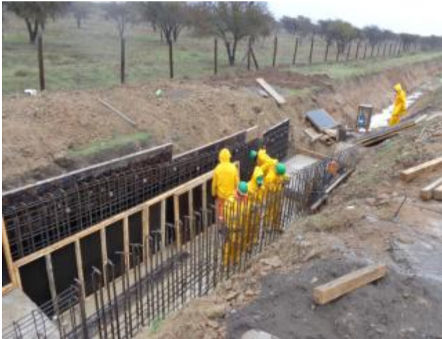
Enfierradura y moldajes para paso predial.
