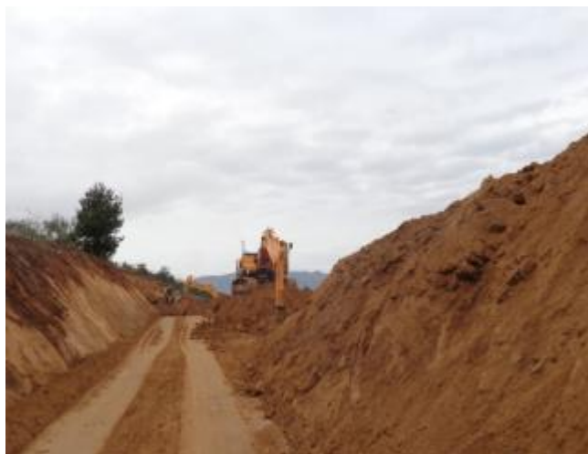
Movimiento de tierras masivo.
