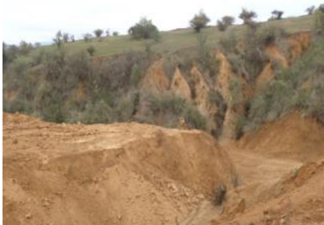
Movimiento de tierras masivo.
