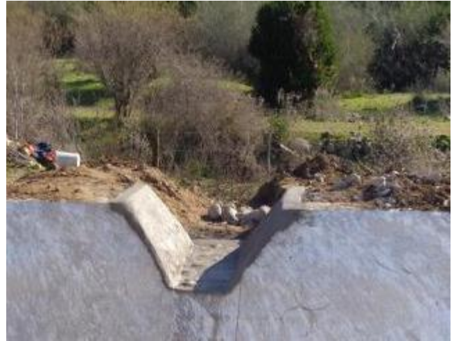
Descarga de quebrada a canal.
