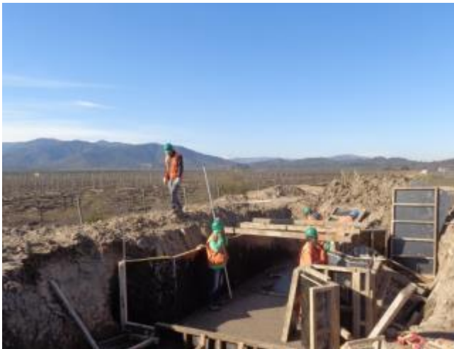
Moldaje para marco partidor en Tranque Vaticano.
