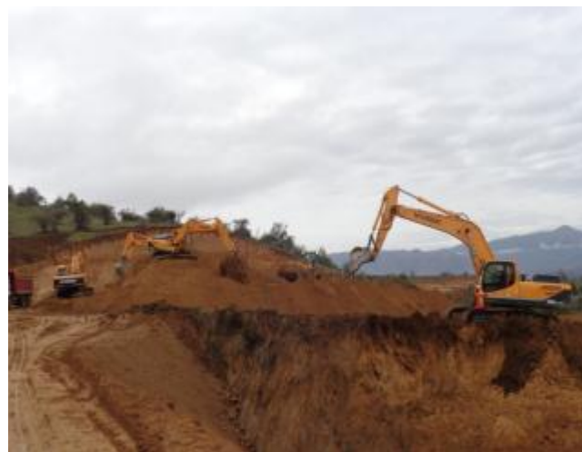
Movimiento de tierras masivo.
