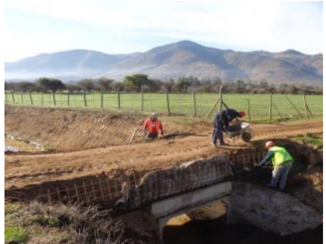
Rellenos con geotextil para acceso a predios.
