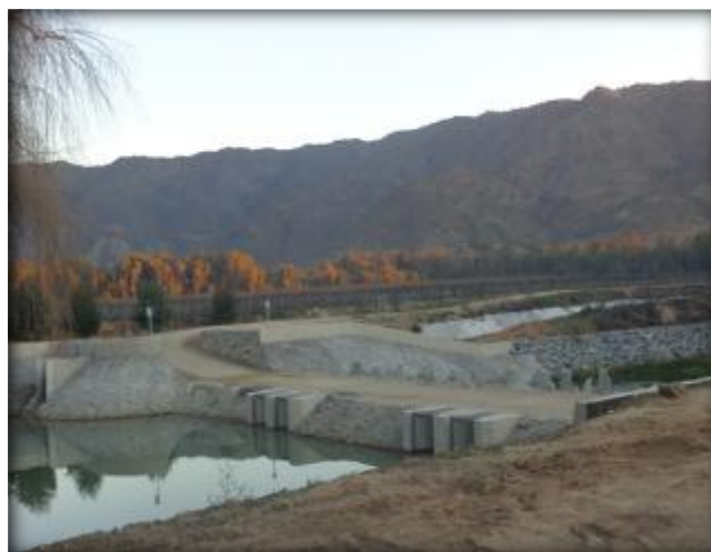
Bocatoma badén, cajones de descarga, enrocado consolidado, cajón de admisión y colchón rugoso.
