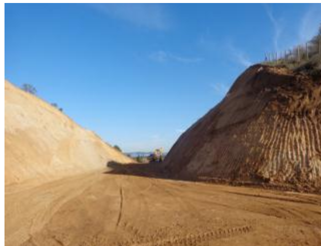
Movimiento de tierras y preparación de plataforma.
